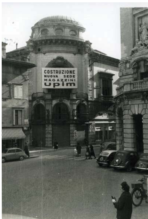
Fig. 2 – Cinema Eden in attesa di demolizione, 1956.
